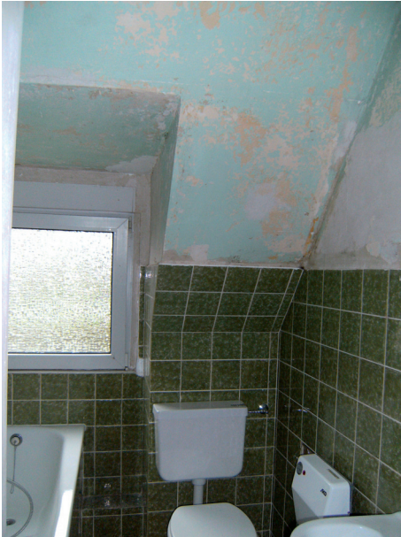
Bruckner Str. 76 Bad vor Umbau
