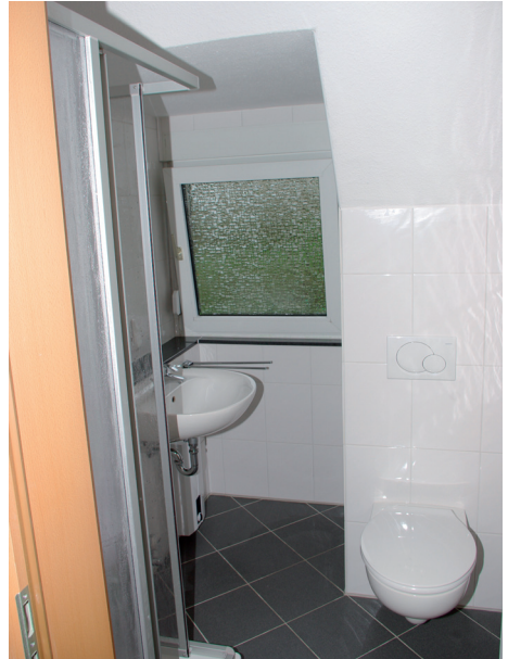
Bruckner Str. 76 Bad nach Umbau
