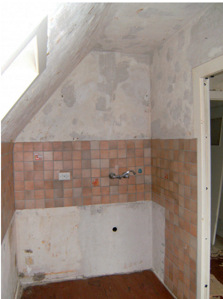
Bruckner Str. 76 Küche vor Umbau
