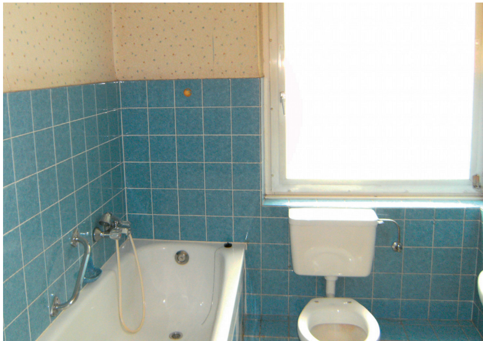
Henshauser Str. 34 Bad vor Umbau
